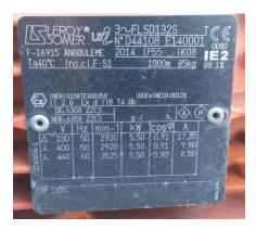
Une plaque signalétique d'un moteur électrique asynchrone nous indique  $P_N = 5.5 \ kW$ ;  $I_A = 9.90$ ;  $U_N = 400 \ V$  (triphasé) et  $\cos \phi = 0.91$ . La puissance absorbée est donc de  $6.2 \ kW$ , soit une valeur supérieure à la puissance nominale.
