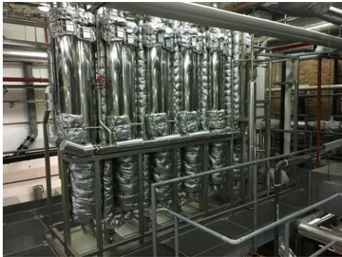
Le local « Power » est le local où sont réalisées la distillation et la production de vapeur process. Malgré les améliorations réalisées sur l'isolation des installations de vapeur, ce local était en surchauffe et nécessitait d'être climatisé.
